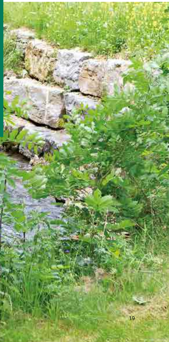
Sanierung mit dem driver@optic®-System
