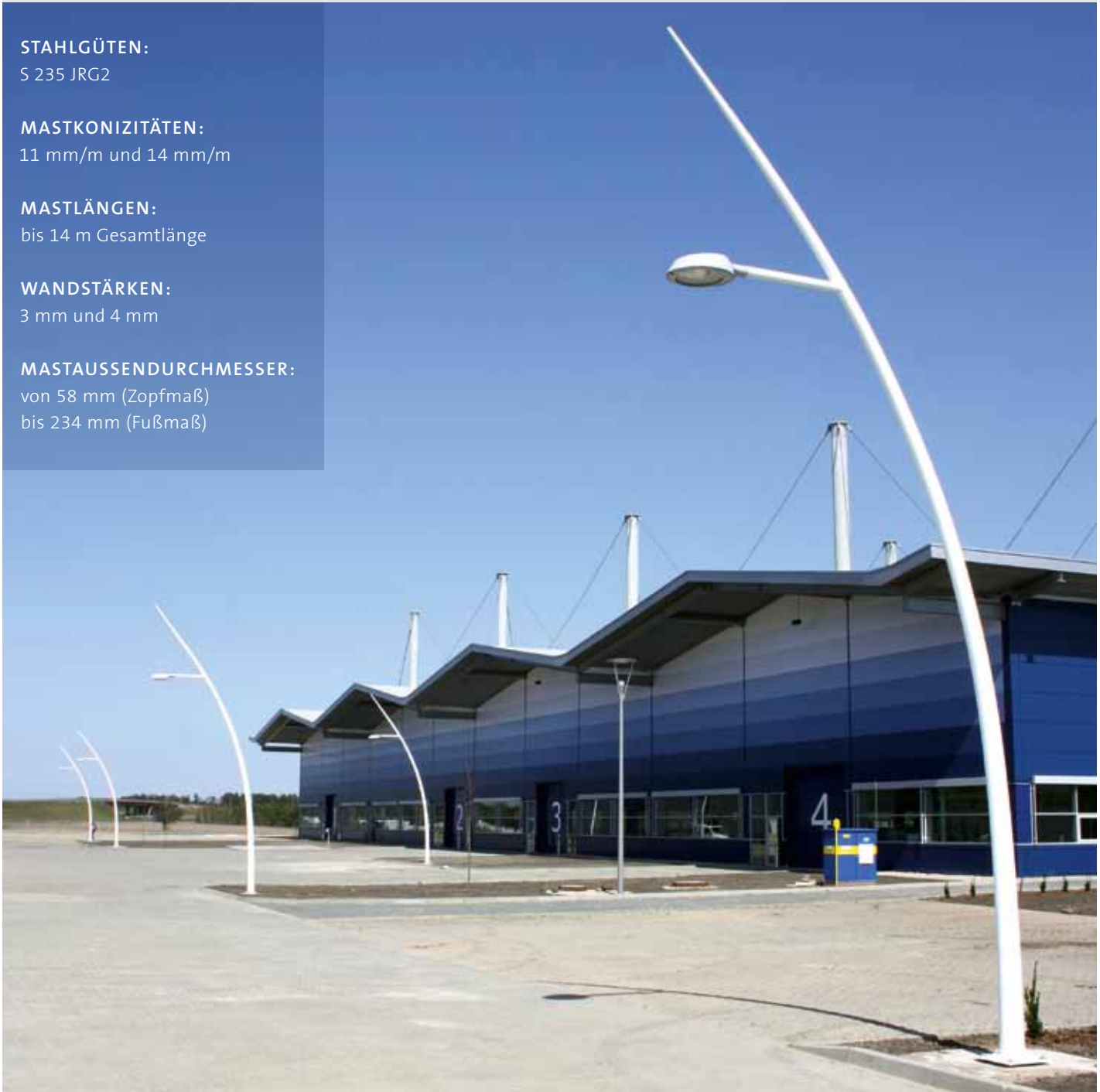
Mittels Laserschweißverfahren hergestellte, gebogene und weiß beschichtete Lichtmasten in Konin/Polen.
