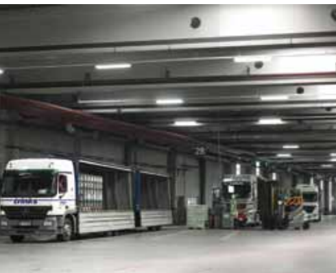
Die Brauerei Krombacher hat durch die Installation einer neuen Beleuchtungsanlage mit hoher Energieeffizienz ein höheres Beleuchtungsniveau bei gleichzeitiger Halbierung der Leuchtenanzahl erreicht.
