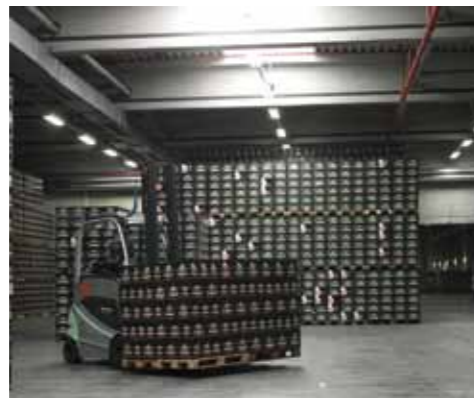
Die Brauerei Krombacher hat durch die Installation einer neuen Beleuchtungsanlage mit hoher Energieeffizienz ein höheres Beleuchtungsniveau bei gleichzeitiger Halbierung der Leuchtenanzahl erreicht.
